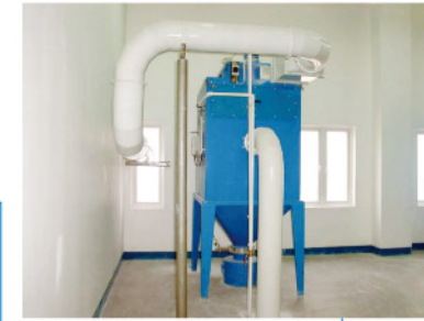
中央除尘器 Central de-dust plant
